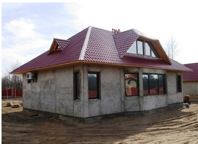
Рис. 2. Возведение малоэтажного здания из монолитного железобетона
